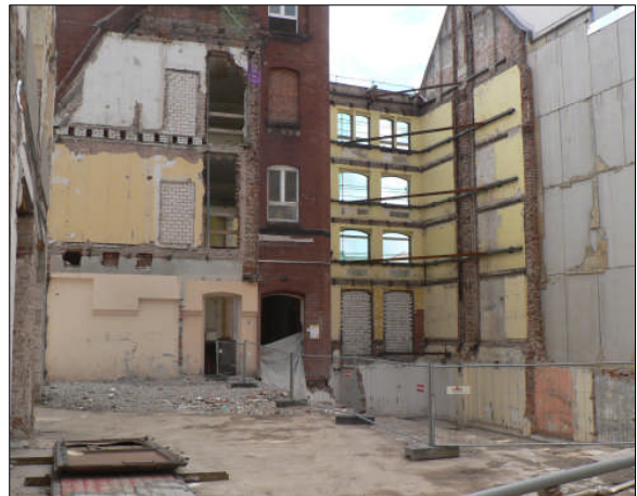
Ansicht der Entkernung am Hirschlachufer
