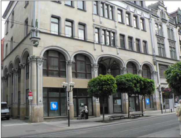
Ansicht Gebäude Anger 21 in Erfurt vor Umbau
