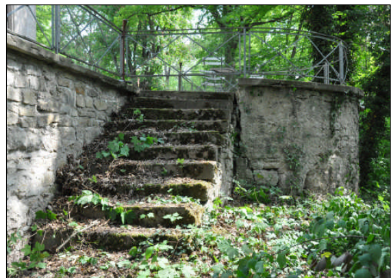
Stützmauer mit Treppenanlage vor Instandhaltung
