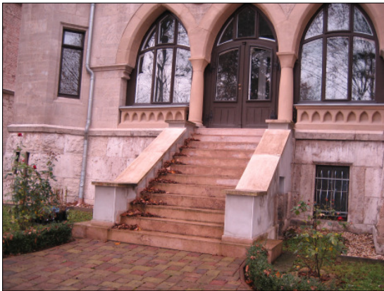
Ansicht des gartenseitigen Eingangsportals
