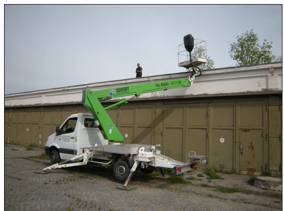
Untersuchung von teerhaltigen Dachversiegelungen
