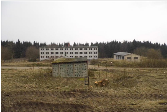
Freifläche mit Unterkunftsgebäude und Garagen
