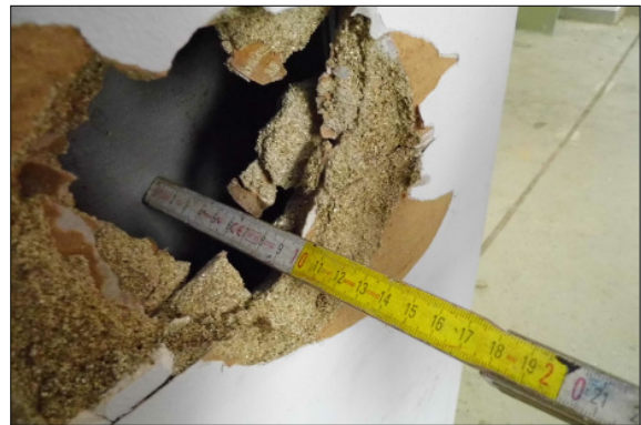
Zwischenwand mit einer Verkleidung aus Vermiculit
