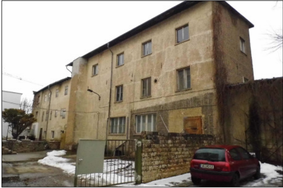
Ansicht Gebäude Amalienstraße 13a
