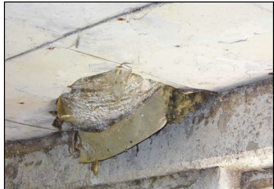
Deckenverkleidung mit Zementasbestplatten und künstlichen Mineralfasern
