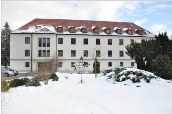
Ansicht Gebäudeteil D
