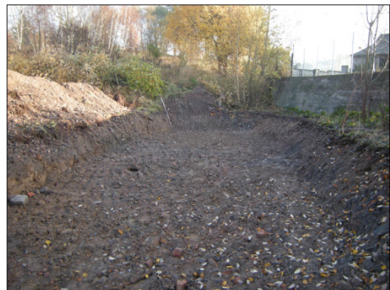
Aushubbereich ehemalige Trafostation
