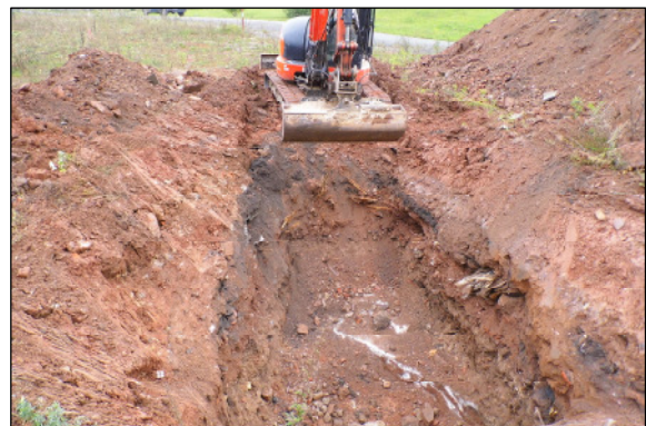
Anlegen von Baggerschürfen zur Erkundung von Altablagerungen
