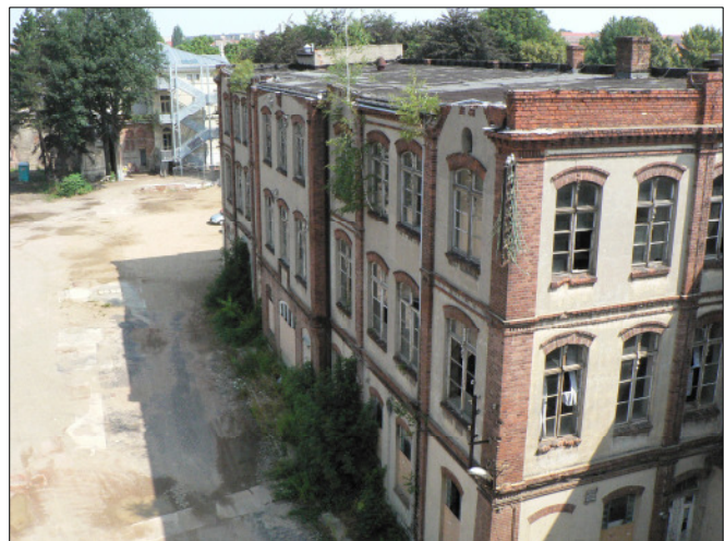
Ansicht Haus K vor dem Abriss
