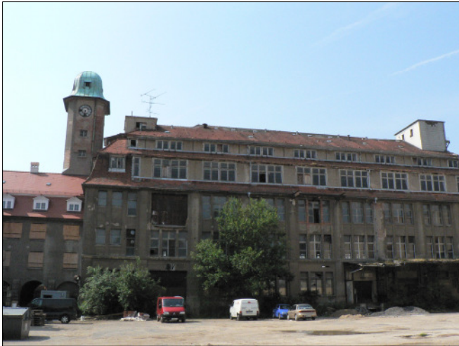
Hofansicht des zu sanierenden Hauses A
