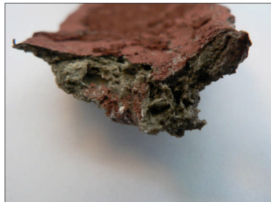
„Morinol“ - Fuge von der Außenfassade
