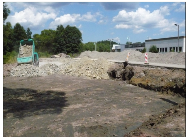
Sanierung der Fläche J
