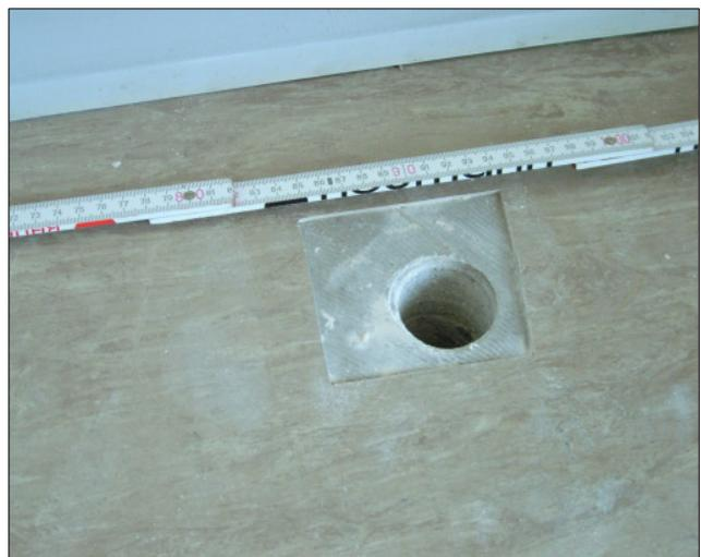
Betonkernbohrung zur Bestimmung des Deckenaufbaus des Krankenhauses
