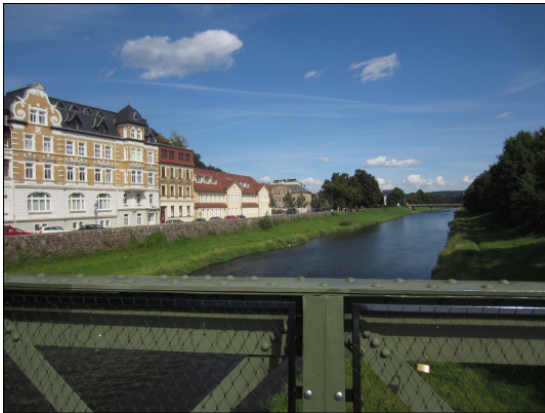
Gesamtansicht der Hochwasserschutzmauer (sh. Bildmitte)
