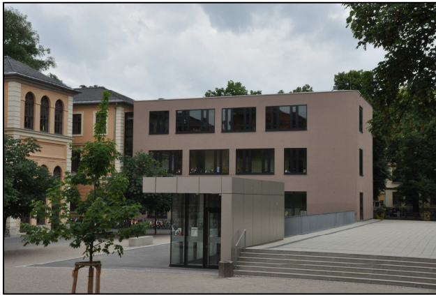
Ansicht der Wieland-Schule und der Innenstadtsporthalle (eingeerdet) nach der Fertigstellung aus Richtung Norden
