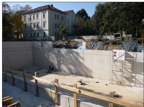
Blick in die Baugrube bei der Herstellung der Außenwände
