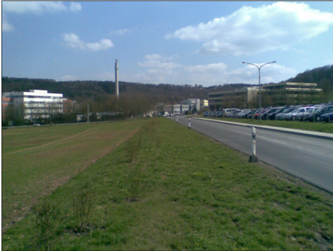
Baufeld vor Abriss der Telekomgebäude
