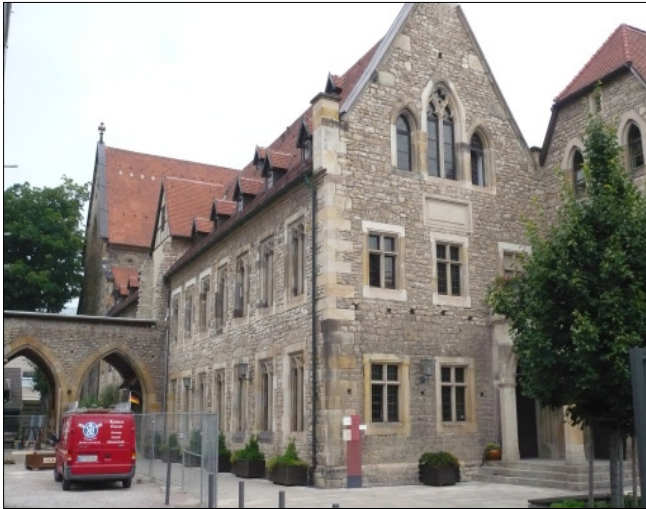
Ansicht des Augustinerklosters vom sanierten Innenhof aus
