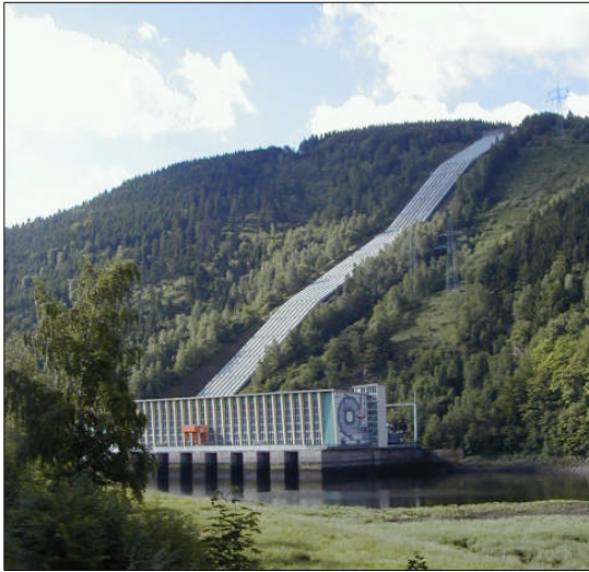
Blick auf die Hangrohrbahn und das Krafthaus
