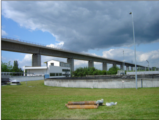
Blick auf die Kläranlage (Hintergrund ICE-Trasse)
