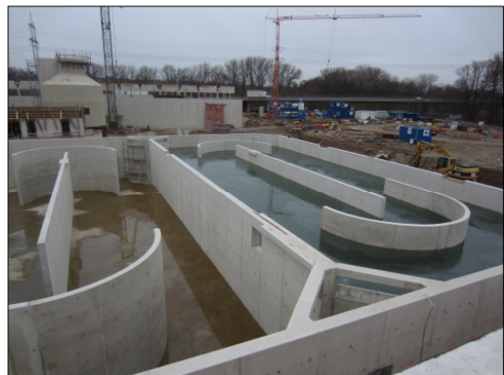
Flutung im Rahmen der Dichtigkeitsprüfung des Belebungsbeckens
