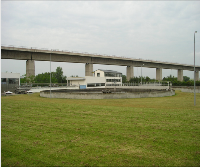
Ansicht Kläranlage (im Hintergrund die ICE-Trasse Erfurt - Nürnberg)
