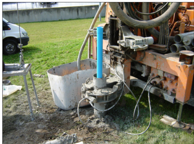
Ausbau der Kernbohrung BK 2 zur Grundwassermessstelle (GWM)
