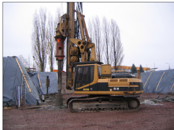
Herstellen von Gründungspfählen in der Baugrube
