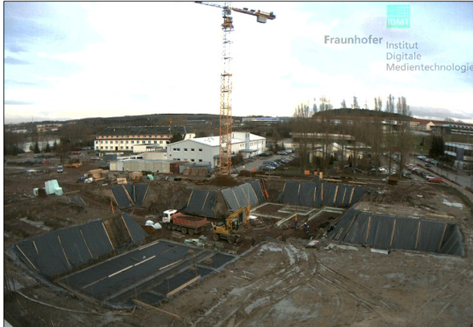
Blick auf die Baugrube im Dezember 2006
