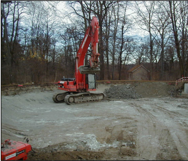
Schirmteich während der Bauarbeiten
