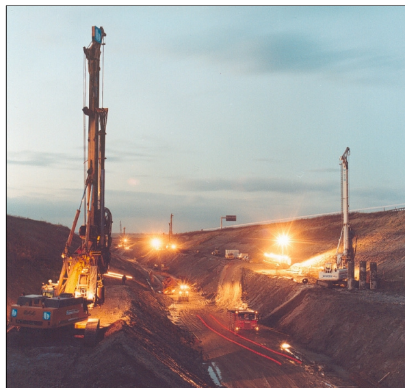
Baugelände während der Pfahlherstellung bei Nacht
