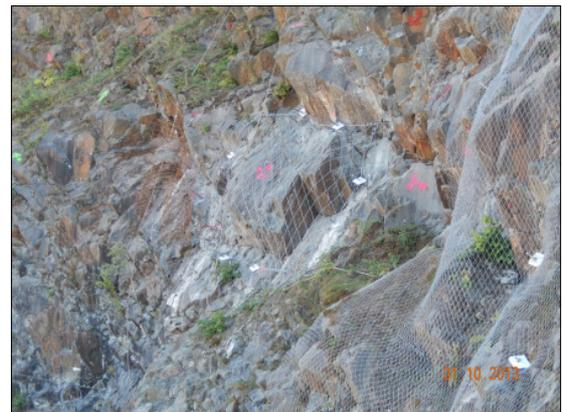
Einzelblocksicherung mit System SPIDER (im Vordergrund Vernetzung mit TECCO, im Hintergrund Bewehrung für Knagge)
