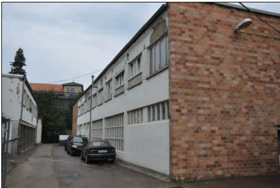
Ansicht bestehende Versuchshalle auf dem Baugrundstück
