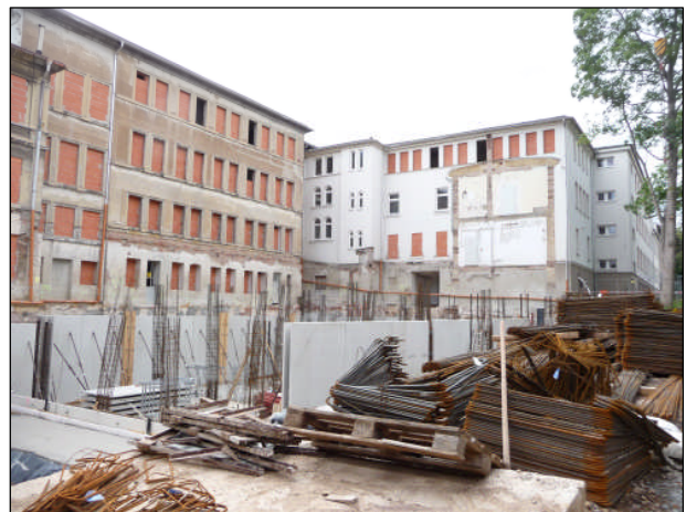
Magazinneubau während der Errichtung des KG
