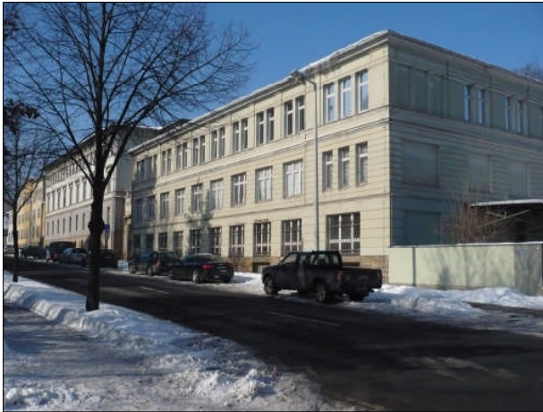
Ansicht des Perthes Forums von der Justus-Perthes-Straße
