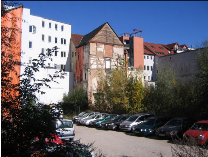
Ansicht des zukünftigen Baufeldes im Oktober 2007
