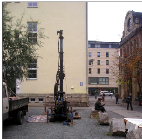
Baugrunderkundung mittels Kernbohrungen
