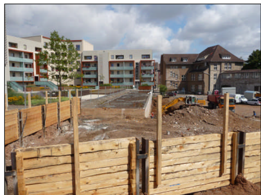
Ansicht Baufeld während dem Baugrubenaushub
