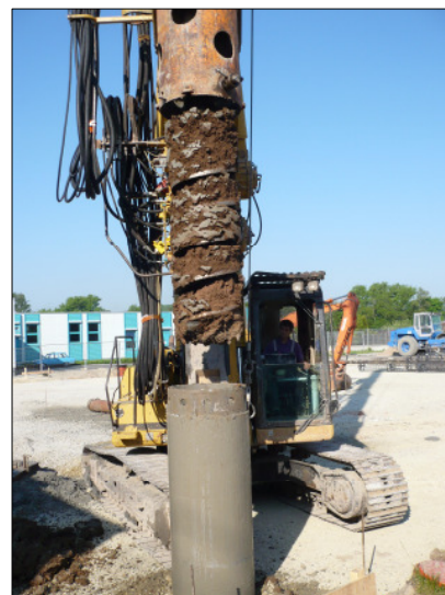
Bohrgerät während der Pfahlherstellung
