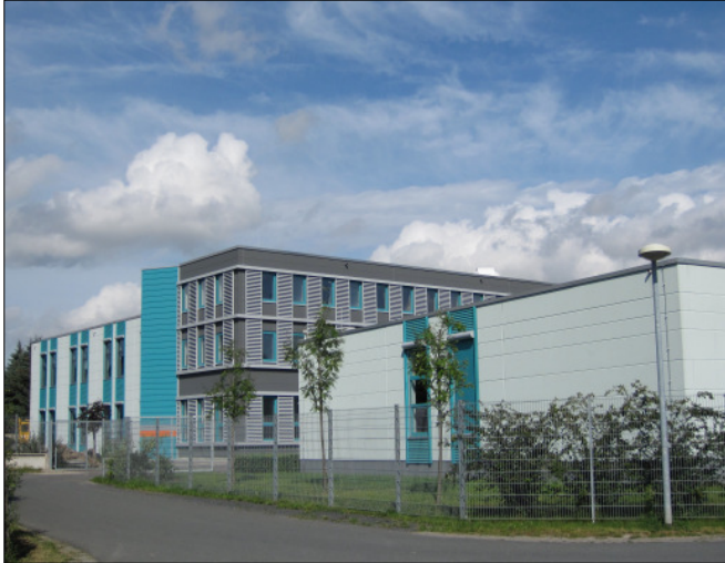
Ansicht des Betriebsgebäudes (Quelle: AB Steinert)
