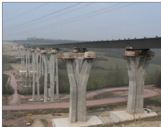
Baufeld Nesselalbrücke während der Herstellung des Überbaus
