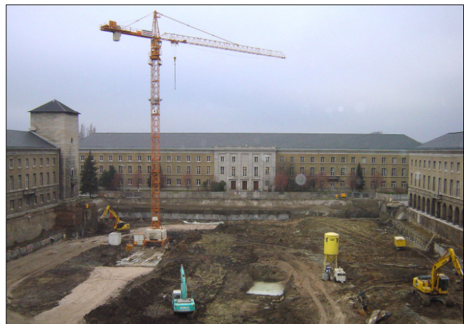
Blick auf die Baugrube für die Tiefgarage
