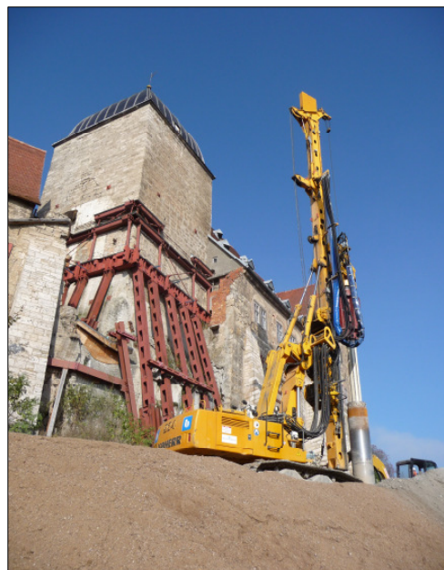
Bohrarbeiten im Oktober 2010
