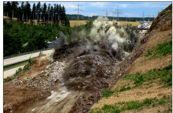
Geotechnische Begleitung der Sprengarbeiten am Einschnitt Görkwitz
