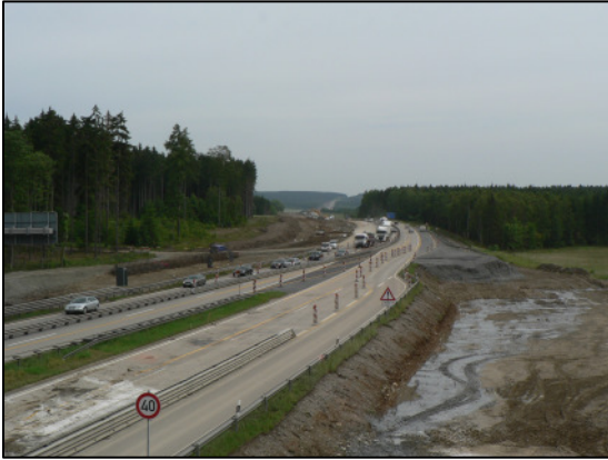
Blick auf die BAB Trasse bei AS Dittersdorf (im Bau)
