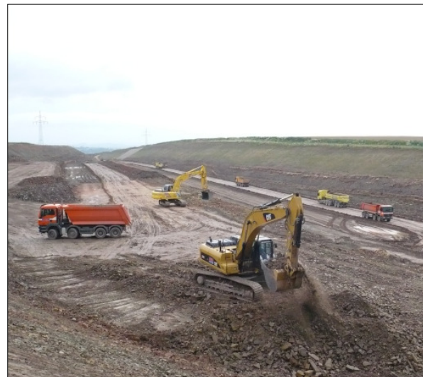
Blick auf die Erdarbeiten an der PWC-Anlage West
