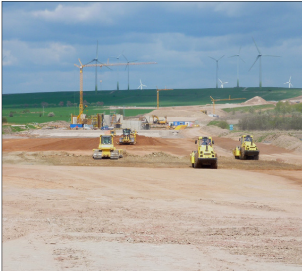
Bauarbeiten an der Trasse der BAB A71 (Quelle: J. Rädlinger)
