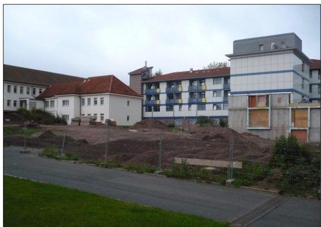
Baufeld zweiter Bauabschnitt
