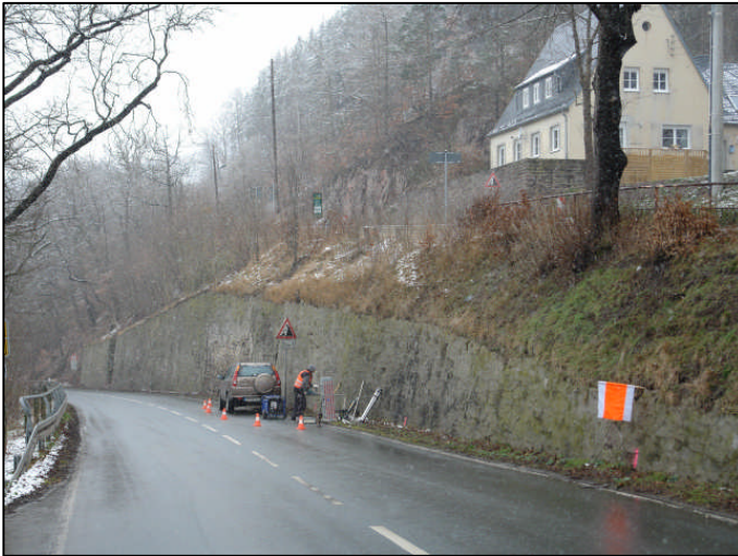
Blick auf die Stützmauer vom Kreisverkehr aus
