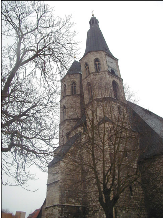
Ansicht der Kirche mit erkennbarer Schiefstellung der Türme
