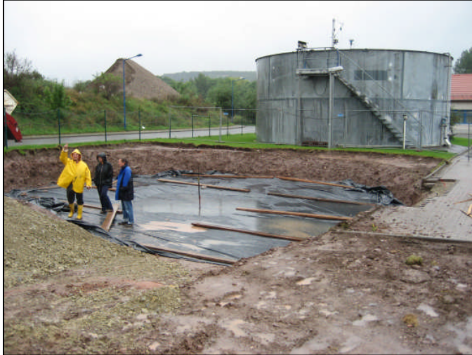
Ansicht Kläranlage während der Bauarbeiten im September 2007
