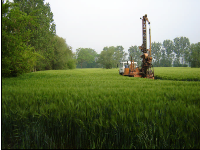
Ansicht Baufeld Kläranlage während der Bohrarbeiten im Juni 2007
