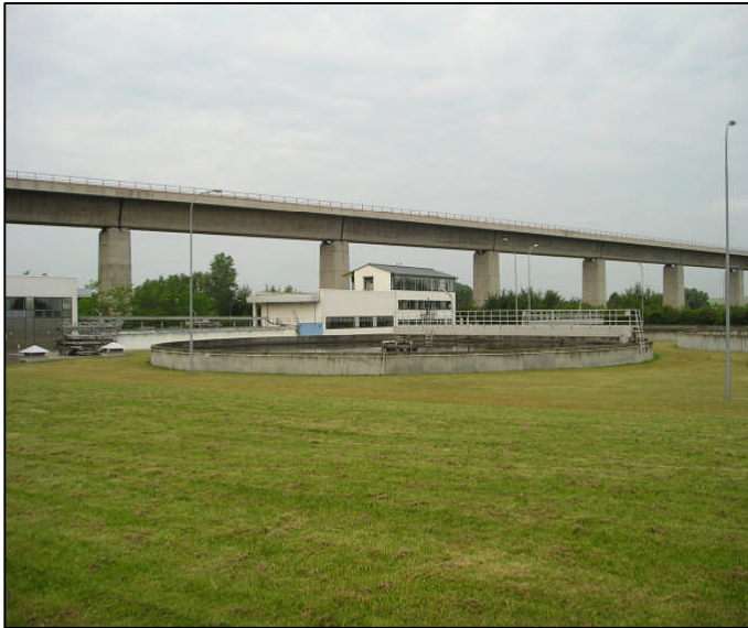
Ansicht Kläranlage (im Hintergrund die ICE-Trasse Erfurt - Nürnberg)
