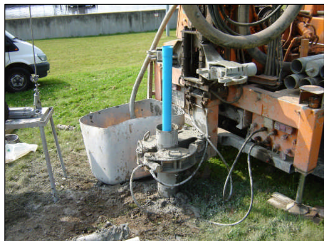
Ausbau der Kernbohrung BK 2 zur Grundwassermessstelle (GWM)
