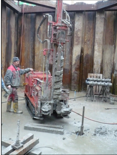
Bohrarbeiten im Zuge der Auftriebssicherung des RÜB Mühlberg
