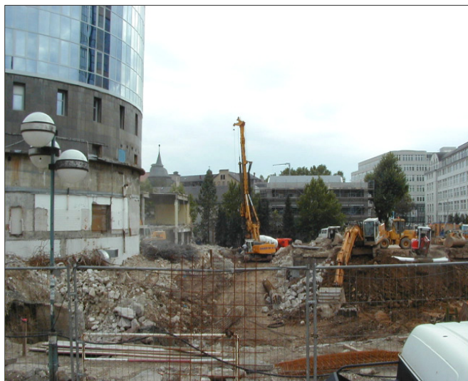
Baugelände während der Pfahlherstellung
