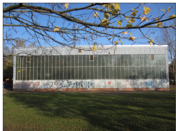
Rückansicht der abzubrechenden Sporthalle
