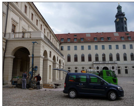
Baugrundbohrungen im Innenhof des Schlosses
