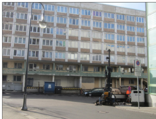
Baufeld mit Gebäudebestand während der Baugrunderkundung
