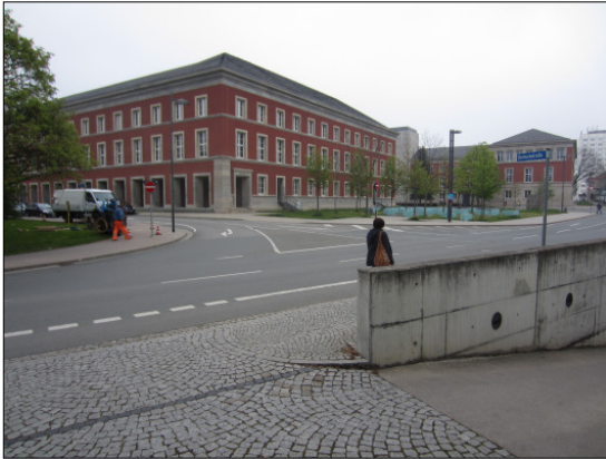
Baufeld an der Bertuchstraße
