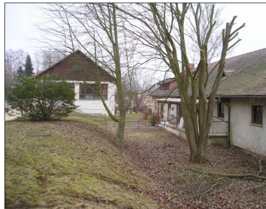
Blick nach Norden (rechts: rückzubauendes Gebäude)
