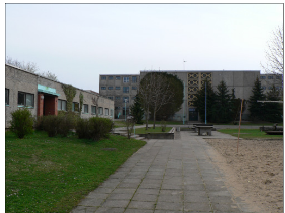
Rückansicht der Schule mit Freiflächen und Sporthalle
