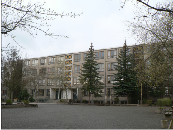
Vorderansicht des bestehenden Schulgebäudes
