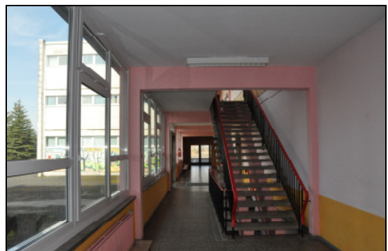
Ansicht des rückzubauenden Verbindungsgebäudes
